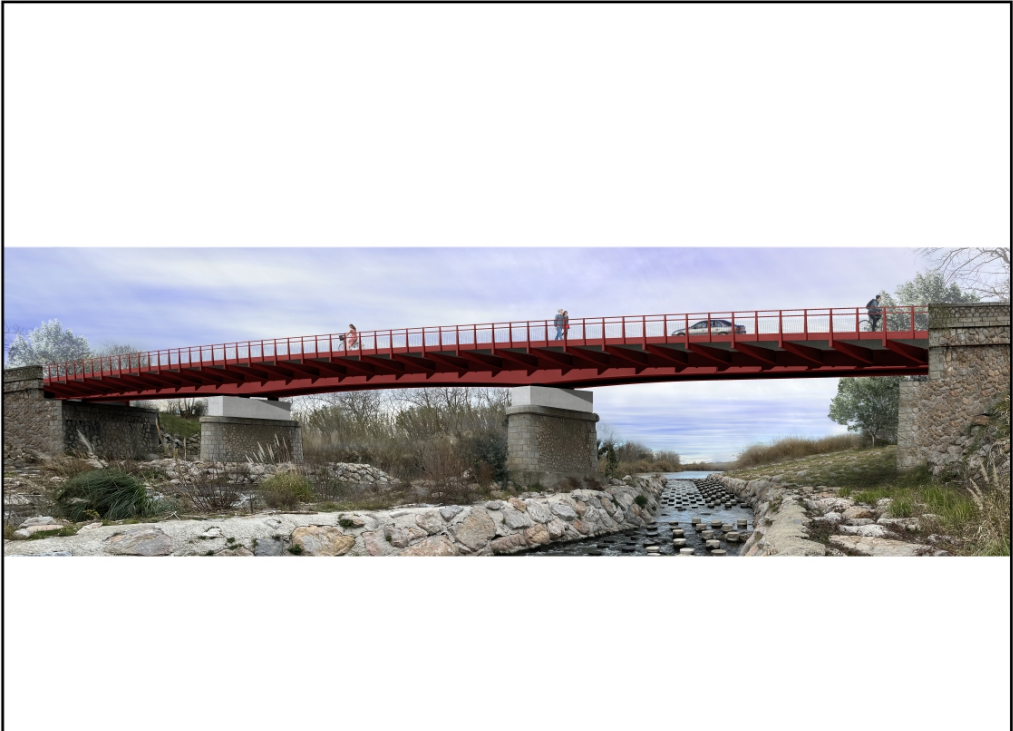
PERSPECTIVE DE L'OUVRAGE VARIANTE 3 OUVRAGE MIXTE / BI-POUTRE (hauteur variable)
