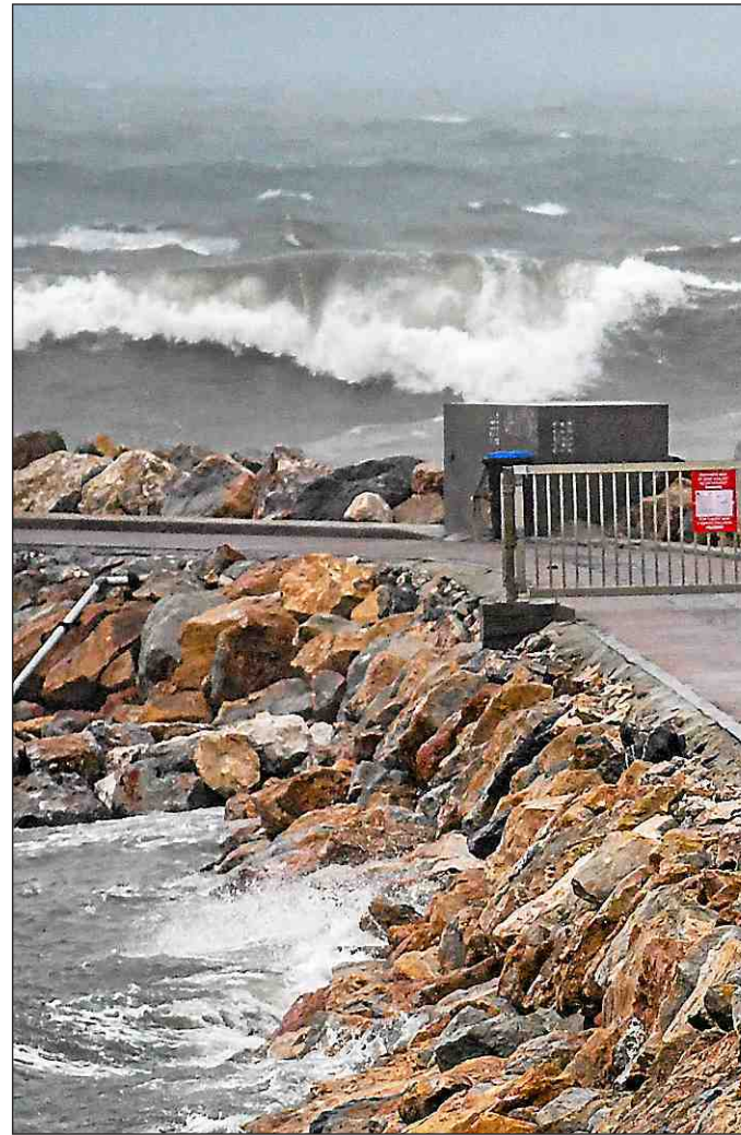
La tempête Gloria en janvier 2020 a causé d'importants dégâts sur
