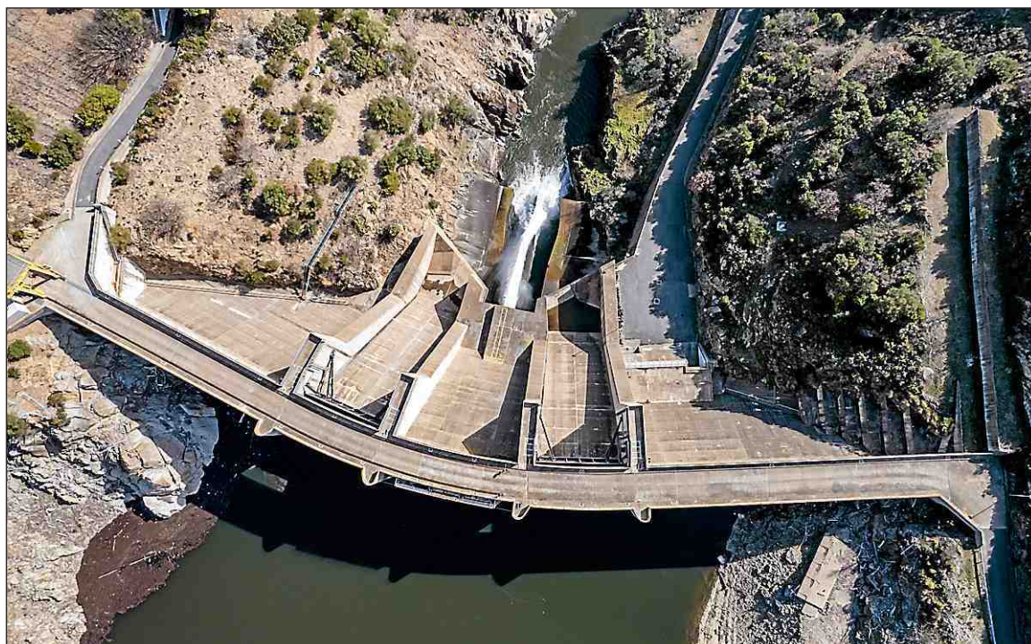
Le barrage de Caramany a été mis en place pour écrêter les crues de l'Agly et protéger la Salanque. ARCHIVES OLIVIER COT
