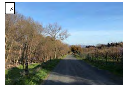
PHOTO 39 : VOIE CIRCULABLE SEPARANT LE LIT DU TECH DES PARCELLES DU SECTEUR (PARTIE NORD)
