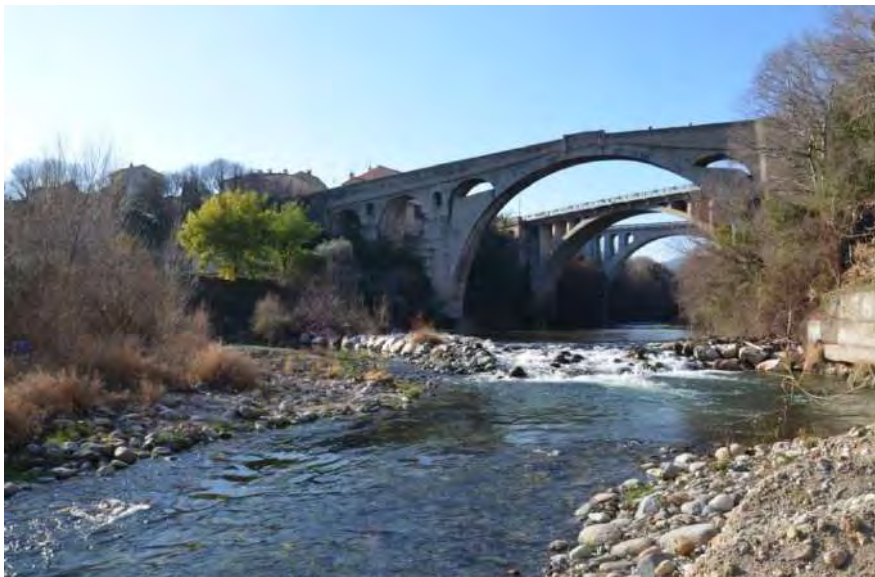
PHOTO 19 : VUE DU PONT DU DIABLE
