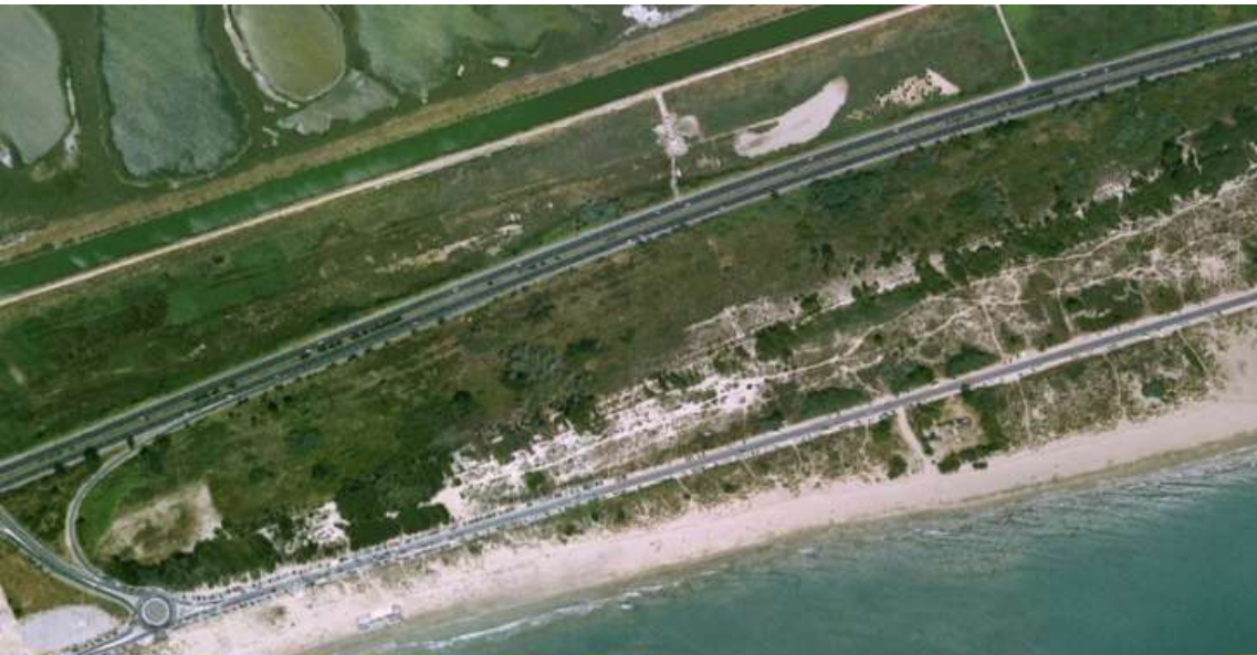
Petit Travers avant travaux
