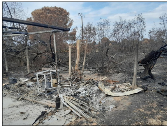
Dégât de niveau 2 : dégâts sur matériels périphériques
