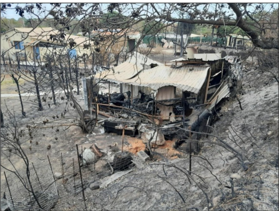
Dégât de niveau 3 : dépendances d'habitation détruites
