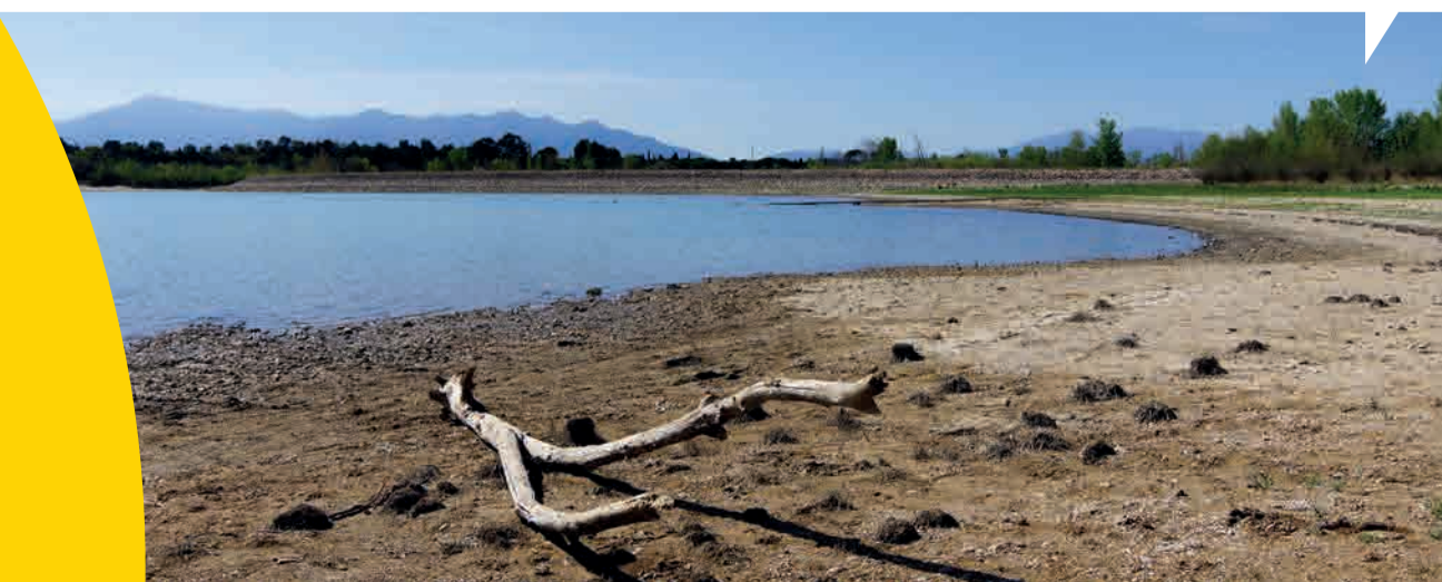
La retenue d'eau de La Raho est aujourd'hui exclusivement réservée à l'irrigation agricole. Elle se remplit principalement en automne et en hiver et au tout début du printemps par le canal de Perpignan, quand le débit de la Têt le permet.
