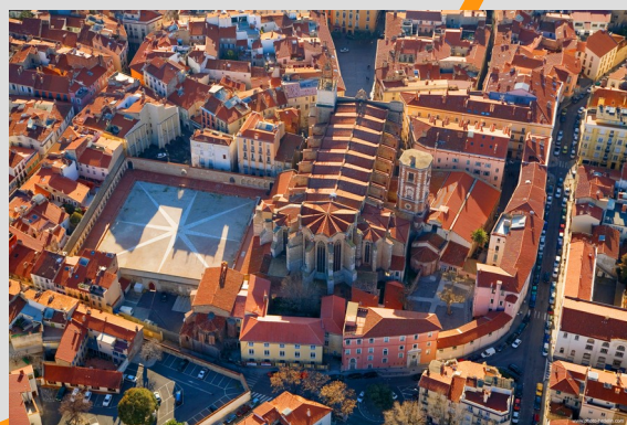
Maison de la catalanité
